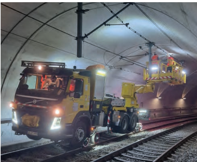
Einsatz des Zweiwegefahrzeugs im Tunnel
