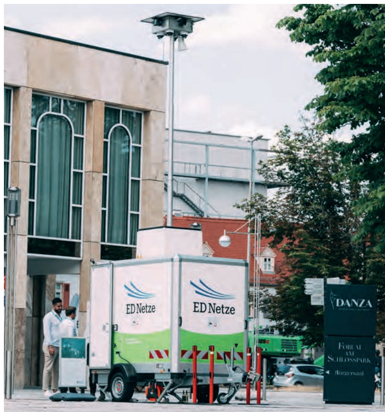
Überwachungs-Anhänger für die ED Netze – konzipiert und ausgeführt durch die Telecom
