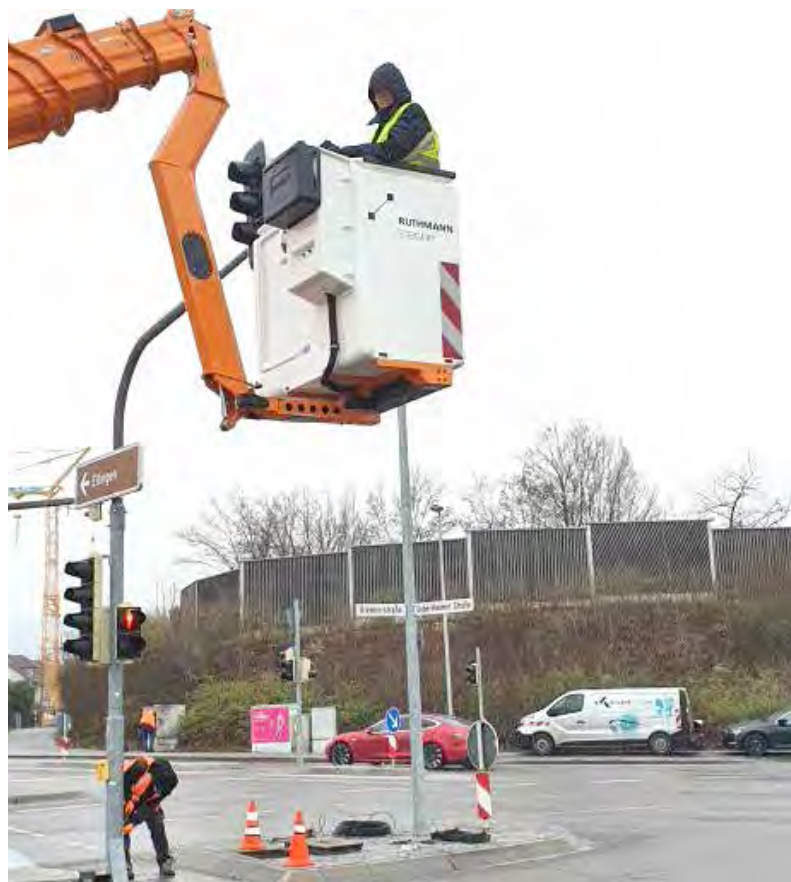
Installation einer Videokamera an einer Leonberger Straßenkreuzung
