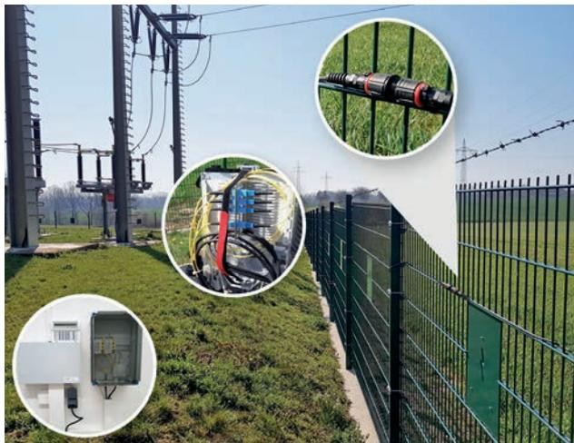
Die gepatchten Glasfaserkabel werden straff in den Zaun eingefädelt und die einzelnen Abschnitte anschließend über Stecker- und Kupplungselemente miteinander verbunden. Beide Kabelenden werden an einem bidirektionalen Switch gepatcht, sodass ein geschlossener Kreis entsteht. (© Kellner Telecom GmbH)
