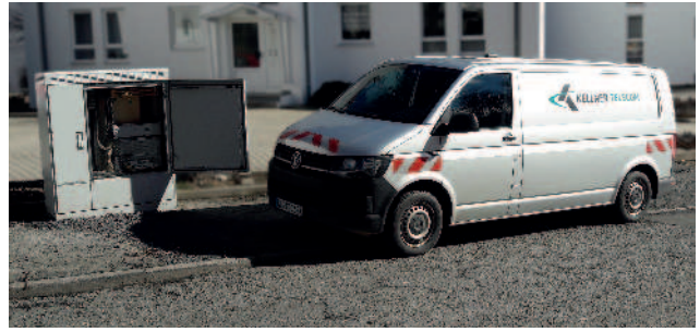
Kellner vor Ort: Arbeiten am MFG
