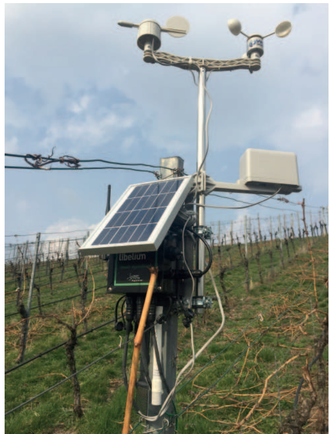
Wetterstation mit Solarmodul
