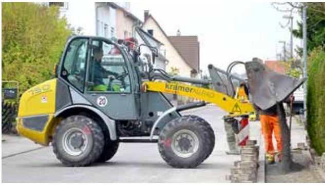
Schließung eines Gehwegs mit Pflastersteinen
