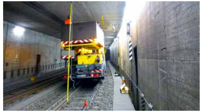
Montage des Richtfunks mit Zweivegefahrzeug und Erdungsstange in der Mitte eines Tunnels der SSB
