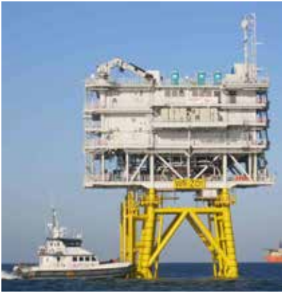
SUBSTATION IN DER NORDSEE
