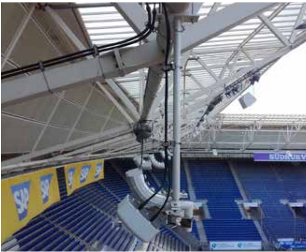
Antennen unter der Dachmembrane
