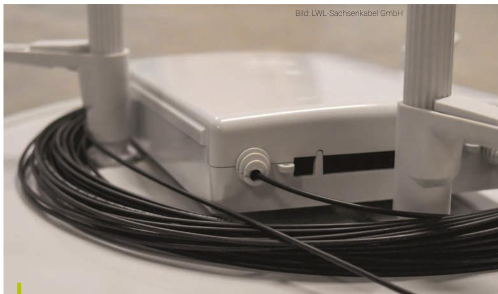
Mit einem mobilen Kabelabwickler und einem tragbaren Einblasgerät können Monteure problemlos das Kabel vom Gebäude zum NVT einblasen.
