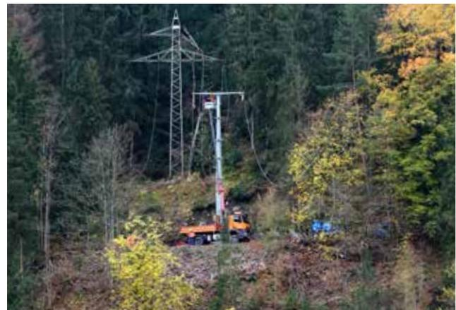
Über 230 Meter sind die 20-kV-Masten am Hohenwarte-Stausee voneinander entfernt. Normalerweise beträgt der Mastabstand ca. 120 Meter.
