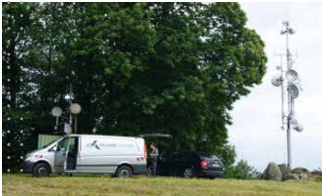
Montage am Mast
